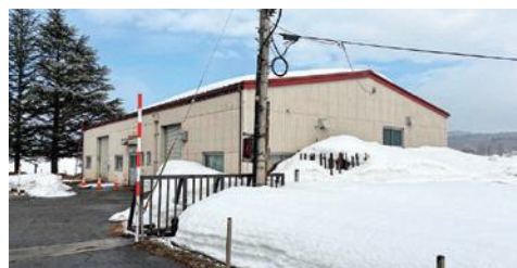
老朽化が進む水道施設
