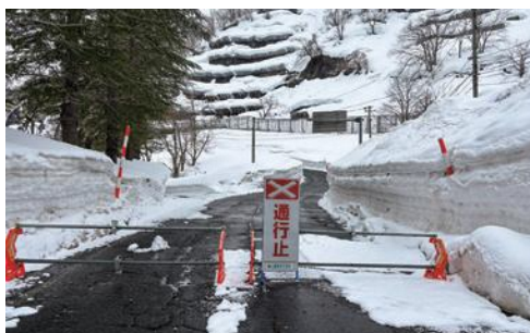
通行止めのダム道路
