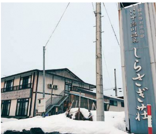
チップボイラーが導入される しらさぎ荘
