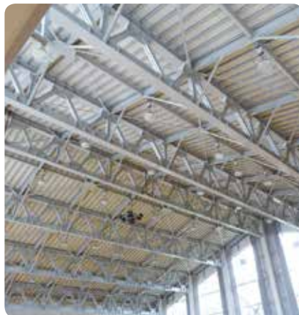
スポーツセンター照明修繕 740万円
