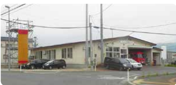
改築が急がれる消防分署
