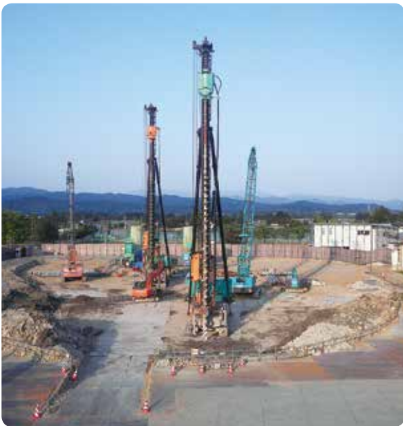
第一小学校杭打ち工事
