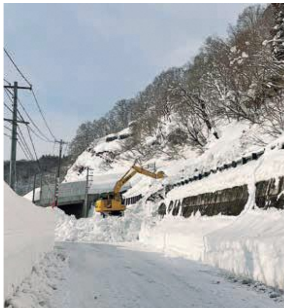
雪崩で通行止めになった通称ダム道路
