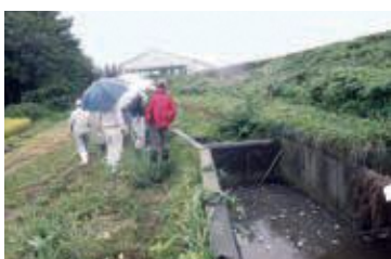
八幡排水路 コンクリート堰の撤去を
