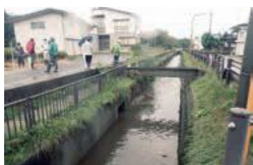
溢れた八幡排水路
