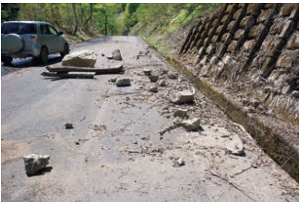
法面の崩落(桧枝岐線)
