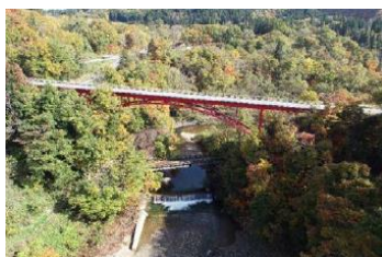
▲須郷橋 (橋長 110.0m) アーチ橋
