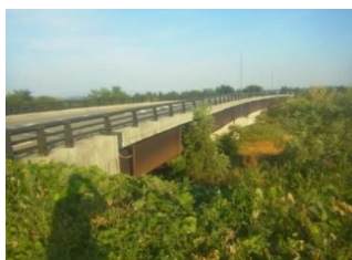
▲飯豊橋 (橋長 213.5m) 鋼橋
