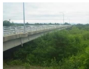
▲上白川橋 (橋長 281.1m) PC橋
